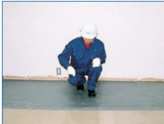
壁面から逃げ寸法を取り基準の墨を打ちます。
